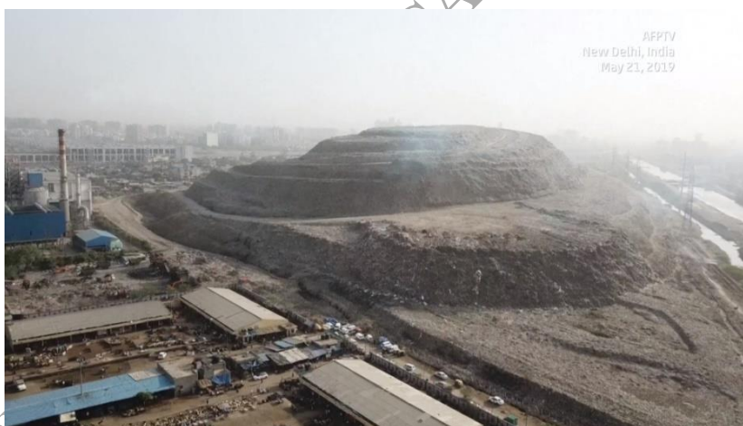
Figura 4. Vertedero de residuos.
